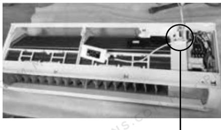
Asegúrese de sacar los cables por el orificio de la tapa de las conexiones para que no estorben al ensamblar la carcasa. Verifique que los seguros tanto inferiores como superiores ensamblen perfectamente
